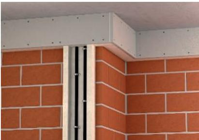
Kabelbefestigung bei senkrechter Kanalmontage mit Schellen.
