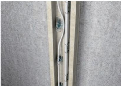
Senkrechte Kabelverlegung mittels Leitungshalter
