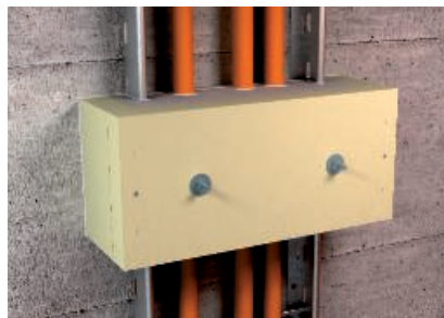
Montage der Zugentlastung in Kombination mit Steigeleitern
