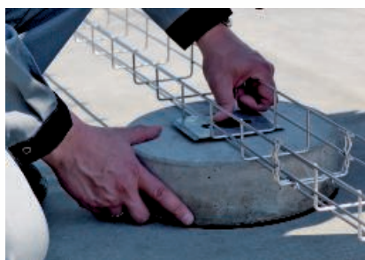
TrayFix Montageadapter und Fixierungsplatte auflegen, festdrücken, fertig
