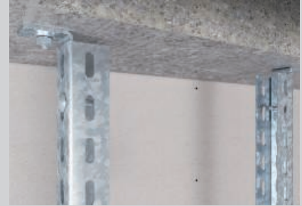
Deckenbefestigung der Leiterholme mit angeschraubten Montagewinkeln.
