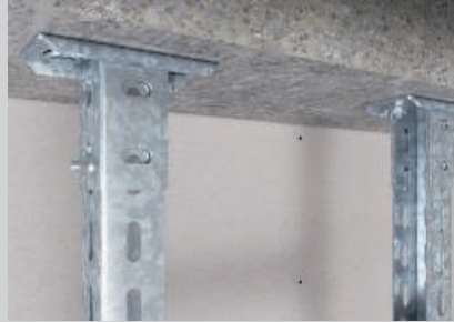
Deckenbefestigung der Leiterholme mit angeschraubten Kopfplatten.
