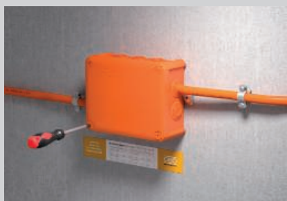
Box mit Deckel schließen und Kennzeichnungsschild anbringen.
