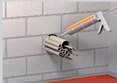
Verschließen der Ringspalte mit Dämmschichtbildner DSX.
