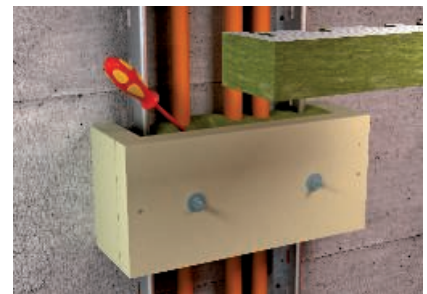
Vollständige Füllung des Gehäuses mit Mineralwolle und einsetzen der oberen Mineralfaserplatte.
