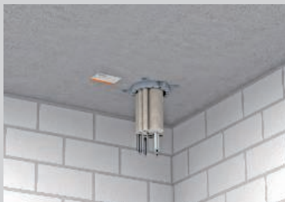
Montage an der Deckenunterseite mit Metalldübeln.
