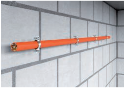
Waagerechte Montage der Kabel an der Wand.
