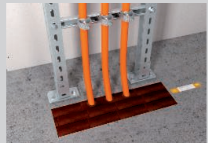
Verschluss der Deckenöffnung mit einem zugelassenen Abschottungssystem.
