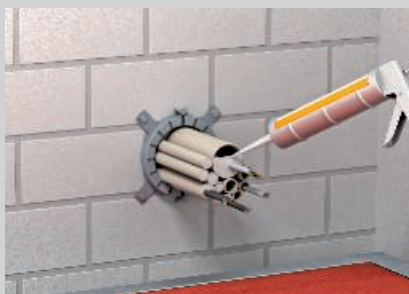
Verschließen der Rohrenden mit Dämmschichtbildner DSX.
