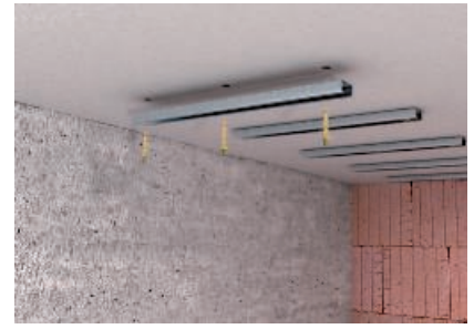
Profilschienen mit für den Untergrund geeigneten Dübeln befestigen. Dübelabstände innerhalb der Schiene maximal 25 cm
