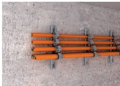
Waagerechte Montage der Kabel mit Bügelschellen an der Wand.
