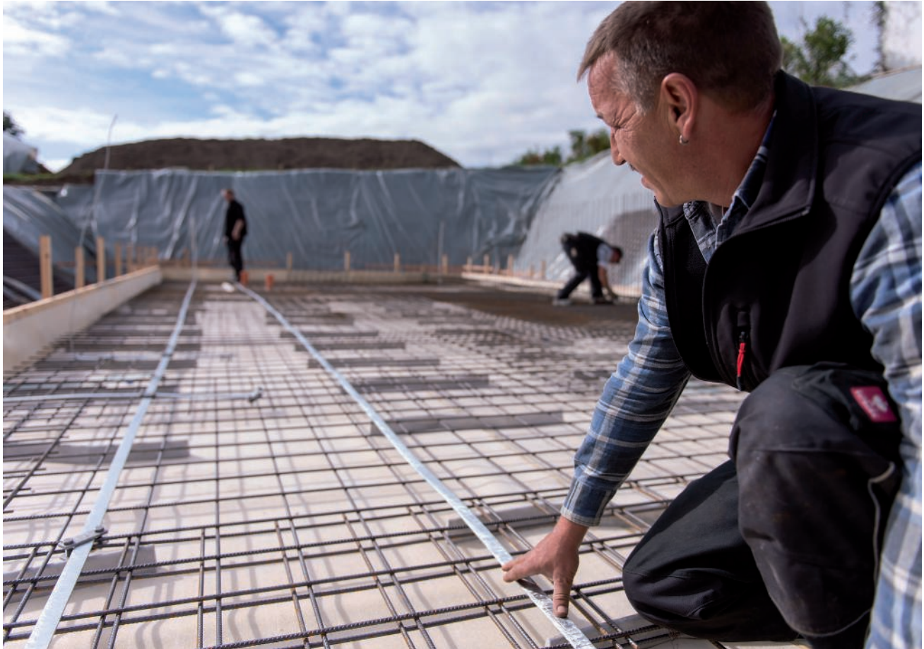
Verlegung eines Fundamenterders
