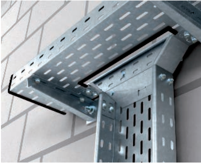
Montage Anbau-Abzweigstück vertikal Vertikaler Einbau des Anbau-Abzweigstücks als Abgangstrichter längs.
