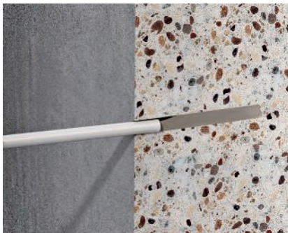
Einbringen des Injektionsmörtels Einpressen des Injektionsmörtels in die Bohrung
