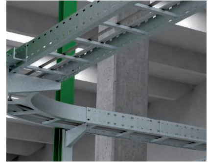
Anwendung Stahlklemmung Montage eines Weitspann-Systems, geklemmt an Stahlträgern.
