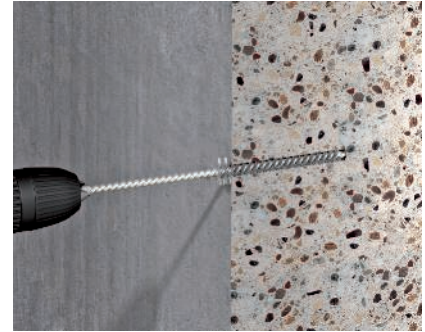
Reinigung mit Stahldrahtbürste Maschinelle Reinigung der Bohrung mit Stahldrahtbürste. Der Reinigungsvorgang mit Ausblasen und Bürsten muss zweimal durchgeführt werden.
