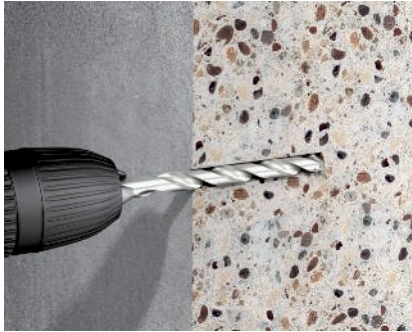
Bohren Herstellen einer Bohrung mit geeignetem Durchmesser
