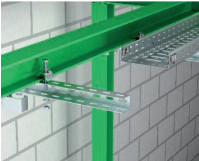
Kragträger an Stahl Montage von U-Stiel als Kragträger an Stahlträger. Befestigung je nach Belastung mit Klemmwinkeln oder Spannklauen. Befestigung mit Distanzstücken Typ DSK.
