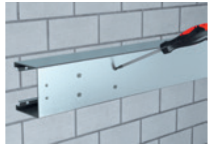
Durchstechen des Brandschutzgewebes im Bereich der Bodenlochung
