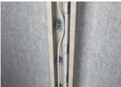
Senkrechte Kabelverlegung mittels Leitungshalter
