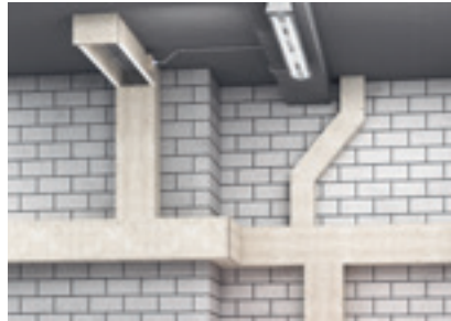
Montierter Brandschutzkanal an Wand und Decke
