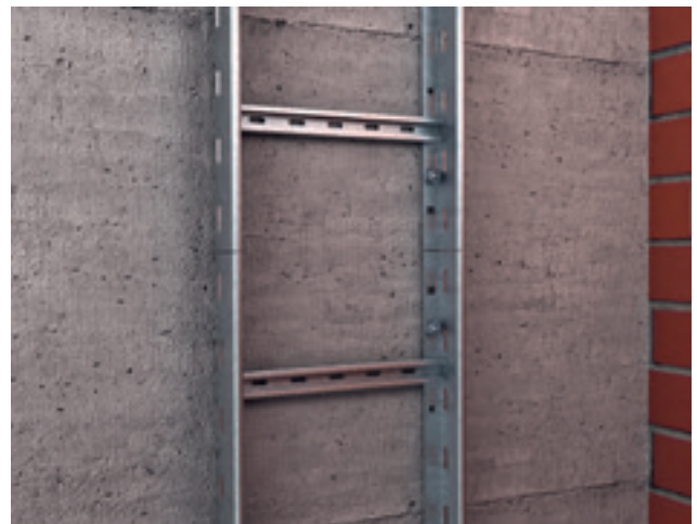
Direkte Montage der Steigleiter an der Massivwand.
